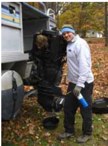
Бик показує неправильну моторову інзоляцію
